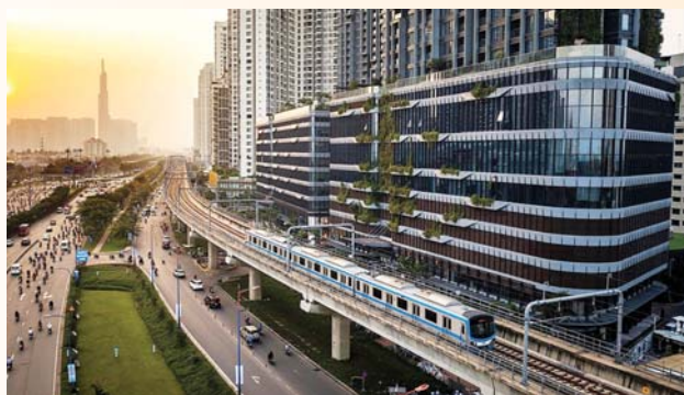
Tuyến metro số 1 Bến Thành - Suối Tiên được đưa vào vận hành và khai thác thương mại làm thay đổi lớn diện mạo TP. Hồ Chí Minh.
